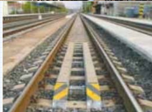
Informační bod v kolejišti
